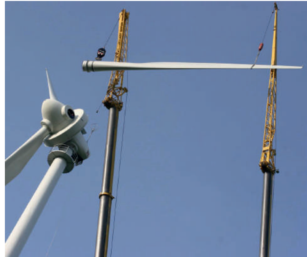
Wechsel der Rotorflügel
